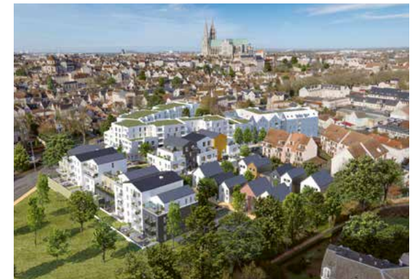
Le « Domaine des Rives », en cours de construction sur le boulevard Clémenceau.
