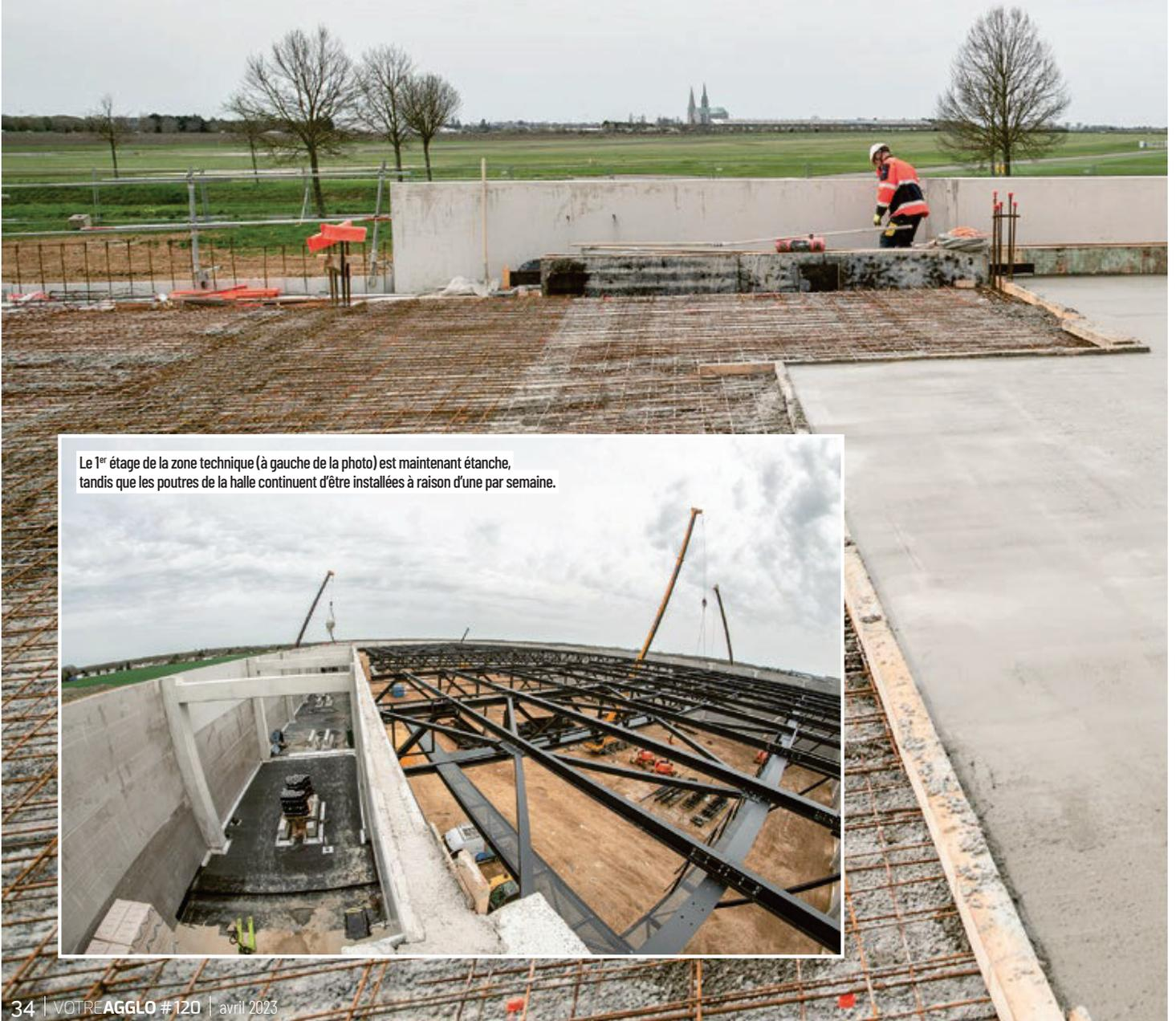
Le 1<sup>er</sup> étage de la zone technique (à gauche de la photo) est maintenant étanche, tandis que les poutres de la halle continuent d'être installées à raison d'une par semaine.
