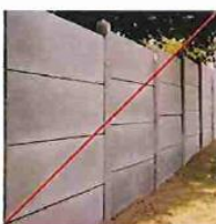
Plaques de béton prémoulées
