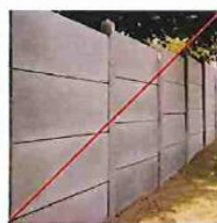
Plaques de béton prémoulées
