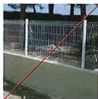
Muret maçonné réhaussé grille souple
