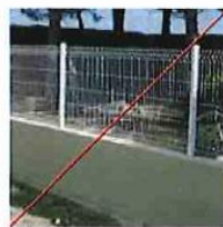
Muret maçonné réhaussé grille souple
