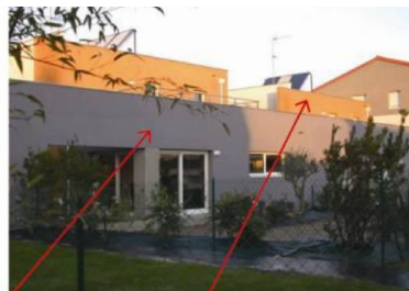
Façade commune aux deux maisons
