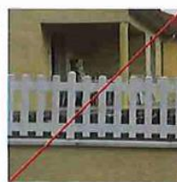
Muret maçonné réhaussé de bardage PVC
