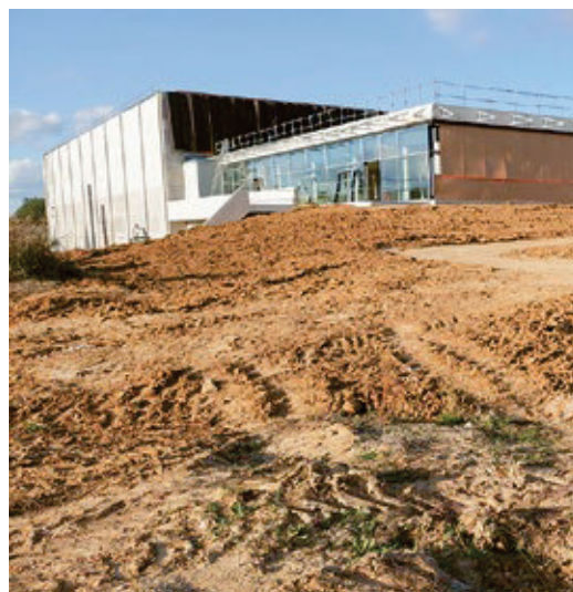
Les abords du restaurant sont réhaussés pour permettre l'accès PMR depuis l'extérieur en pente douce, alternative à l'ascenseur intérieur.
