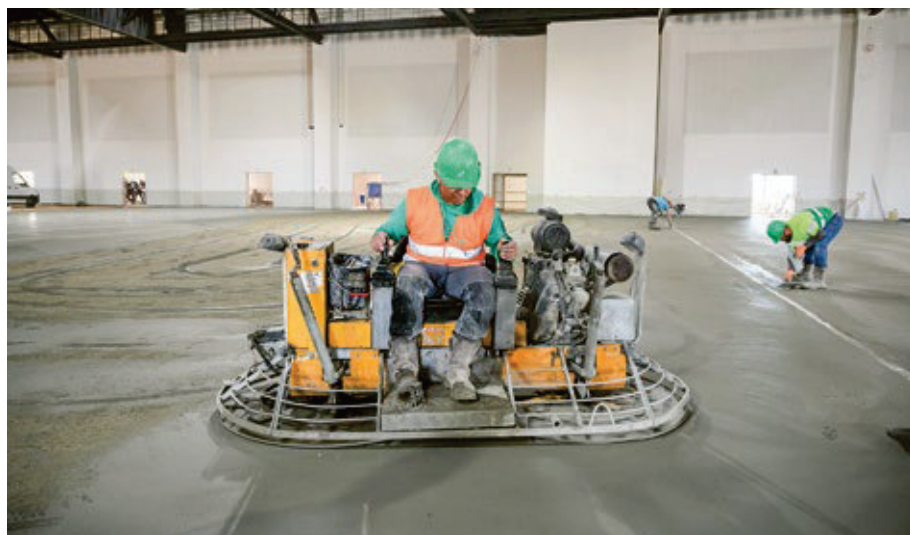
En fin de journée, quelques heures après le coulage, les compagnons talochent le béton à l'aide d'un appareil appelé « hélicoptère », doté d'un système de pales qui permet de lisser la surface.
